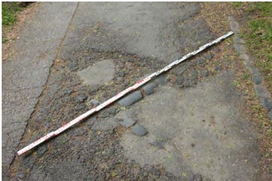
Abb.7: Unter Asphaltdecken hervorkommende Diagonalbänder des historischen Pflasterweges (Drexel, 2011).
