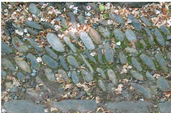
Abb.9: Verlegeprinzip - Freigelegte Kieselpflasterung 2005 (Drexel, 2011).
